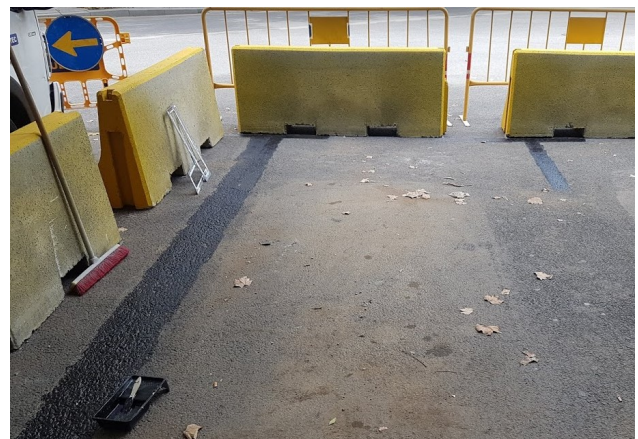
Eliminació de pintures prèvies
